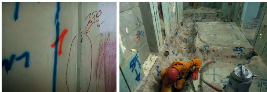
図 6 ホットスポットのマーキングと VAK での再加工
