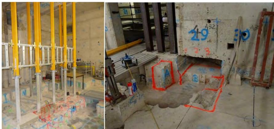
図 7 KTE での再加工のための追加の静的測定とマーキング
