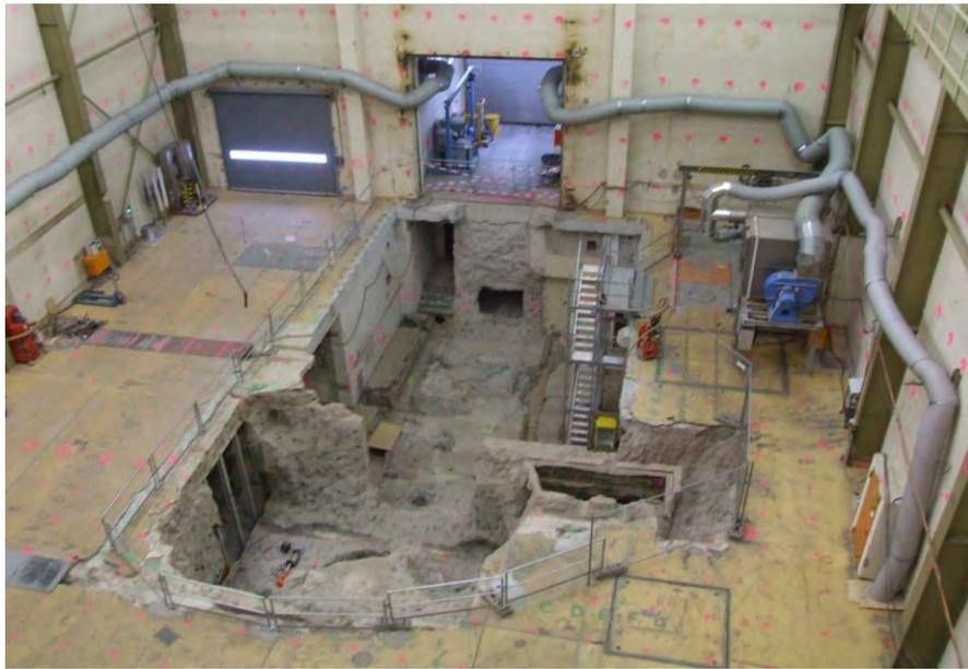
図 5 研究センターの再加工された区域と交換用換気ダクト
